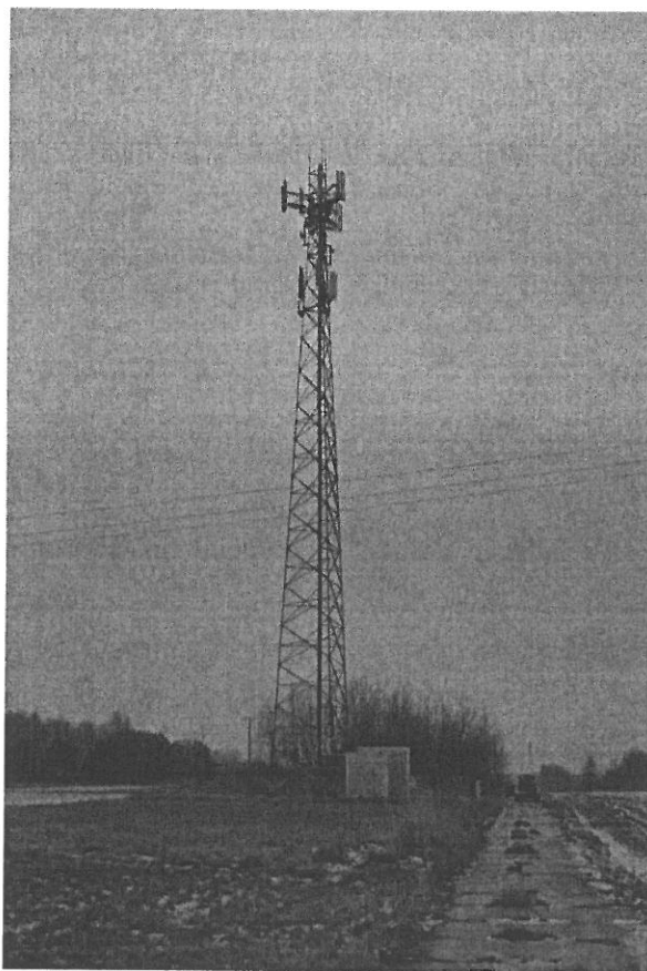
Zał. nr 1: Widok ogólny instalacji radiokomunikacyjnej.
