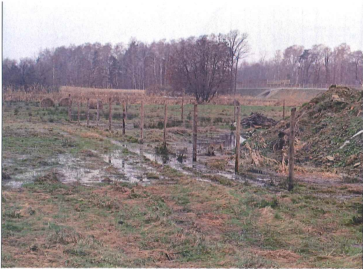
Załącznik 2. Zdjęcia prezentujące zalegającą wodę na terenach PU7 oraz U9.
